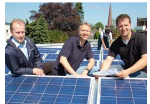
Gute Zusammenarbeit: Patric Stege (v.l., Stadtwerke), Jens Zwicker (Gebäudemanagement Stadt Wedel) und David Bay (NDB energieKonzepte).
